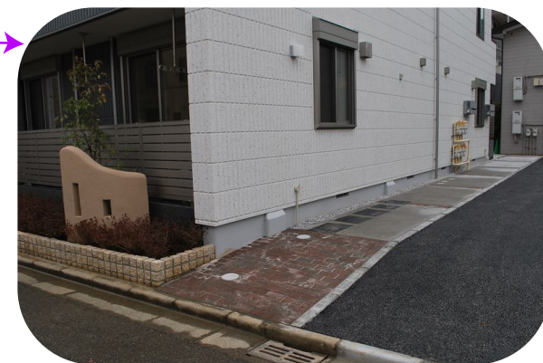
東側アプローチ
